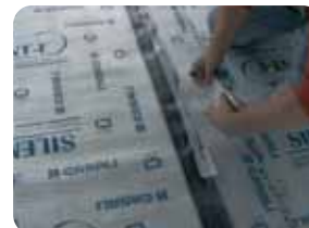
4. stabilizzazione del manto tramite nastratura delle giunzioni.
