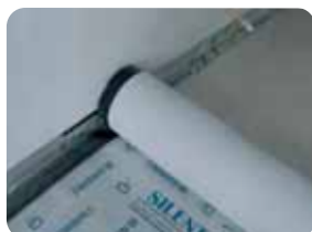
2. srotolamento dei teli
