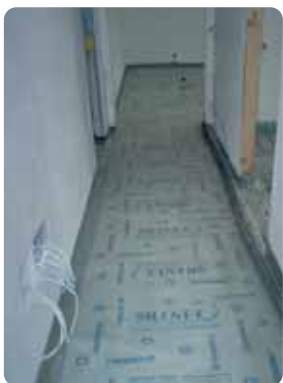
5. posizionamento della rete antiritiro del massetto di regolarizzazione
