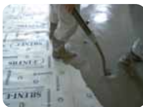
6. getto del massetto di regolarizzazione
