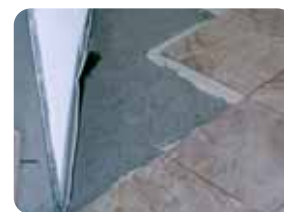
8. posa pavimento finito
