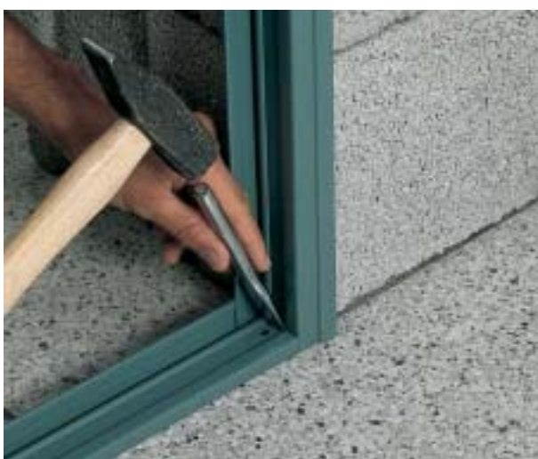
Distanziale inferiore asportabile manualmente.
