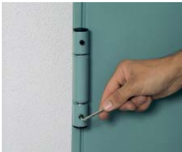
Cerniera portante dotata di viti per la registrazione verticale e sfere reggispinta.
